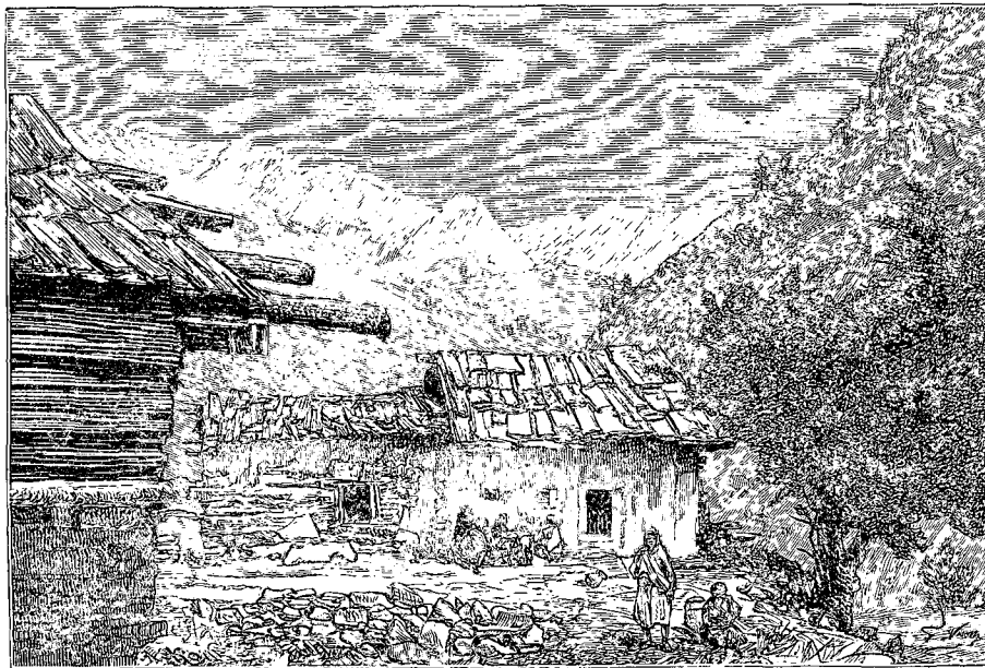
Une maison dans le Koulou (voy. p. 216). — Dessin de G. Vuillier, d'après une photographie de M. Prith.
