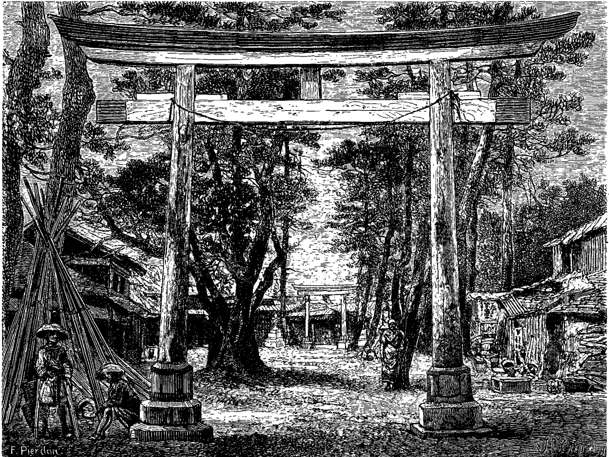
Tori ou porte sacrée à Benten. — Dessin de Tirpenne d'après une photographie.
